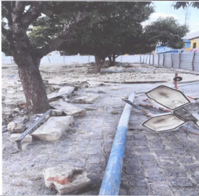
REMOÇÃO DE TRAMAS DE MADEIRA E TELHAS E PILARES
